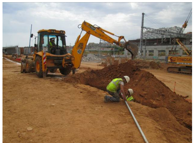
24. Inici de l'excavació de la rasa
