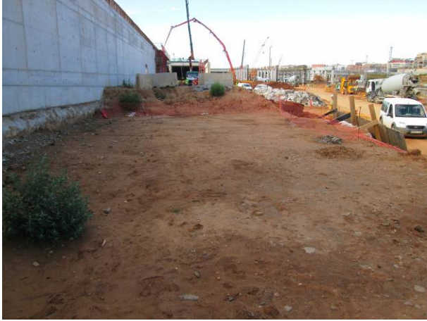
1. Estat inicial de l'àmbit d'actuació
