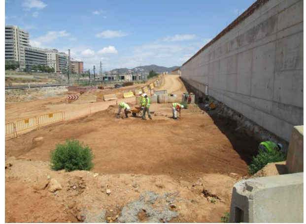
2. Inici dels treballs de neteja i delimitació
